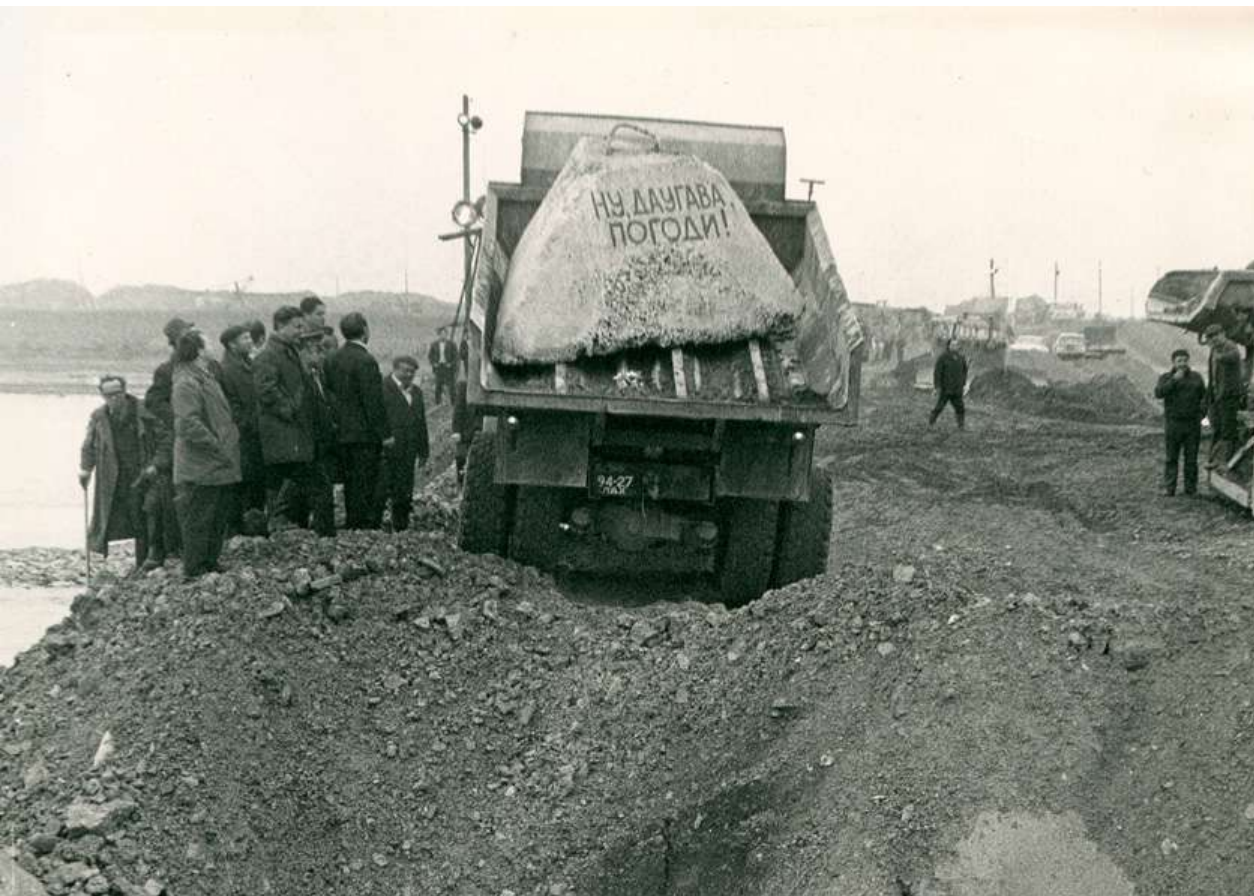
Pagaidu aizsprotojuma izveide
